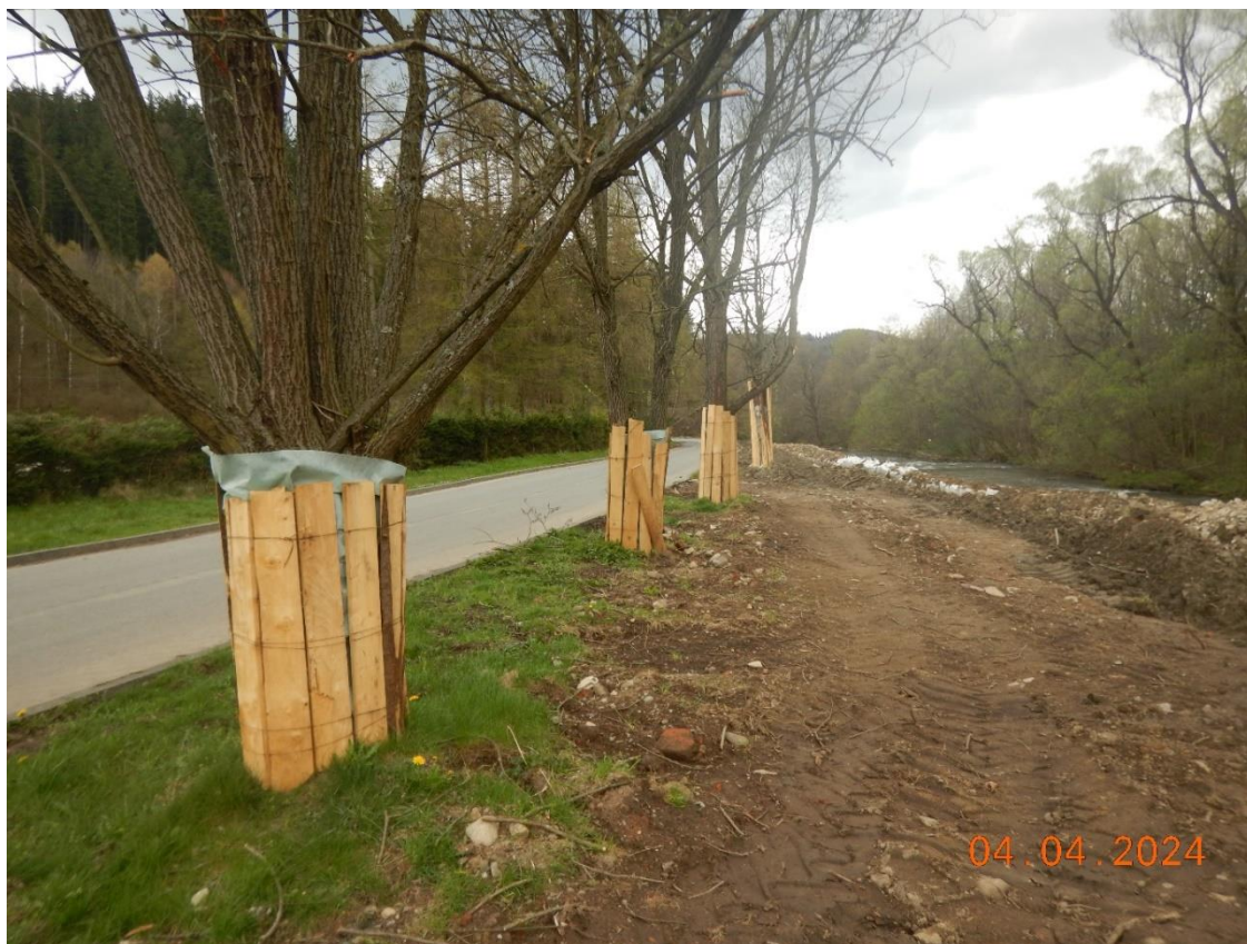
Fot. 4. Zabezpieczenie drzew nieprzeznaczonych do wycinki na Placu Budowy (poz. 22).
