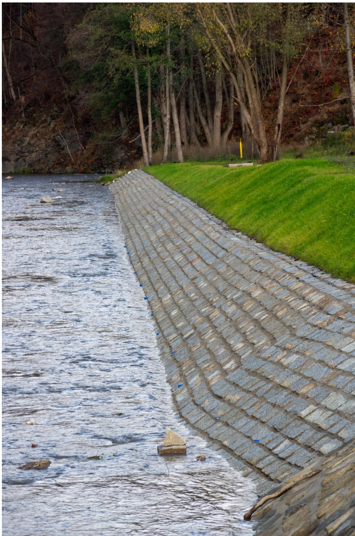
Fot. 25. Łądek Zdrój – odbudowane umocnienie skarpowe.
