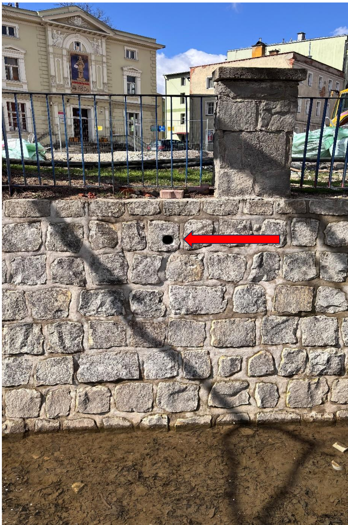
Fot.6. Czerwona strzałka wskazuje wykonaną niszę lęgową dla ptaków w murze oporowym (poz. 70).
