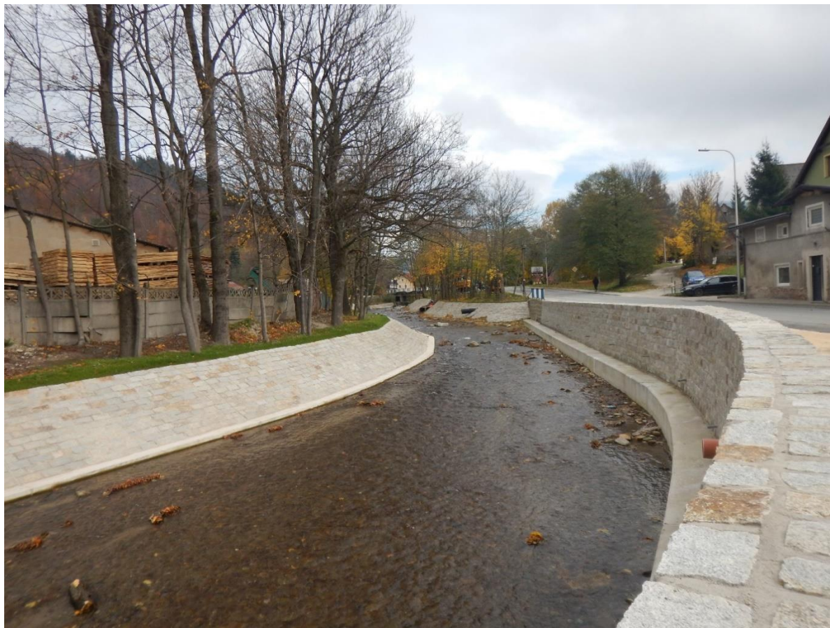
Fot. 23. Stronie Śląskie – widok na odbudowany mur oporowy i umocnienie skarpowe.
