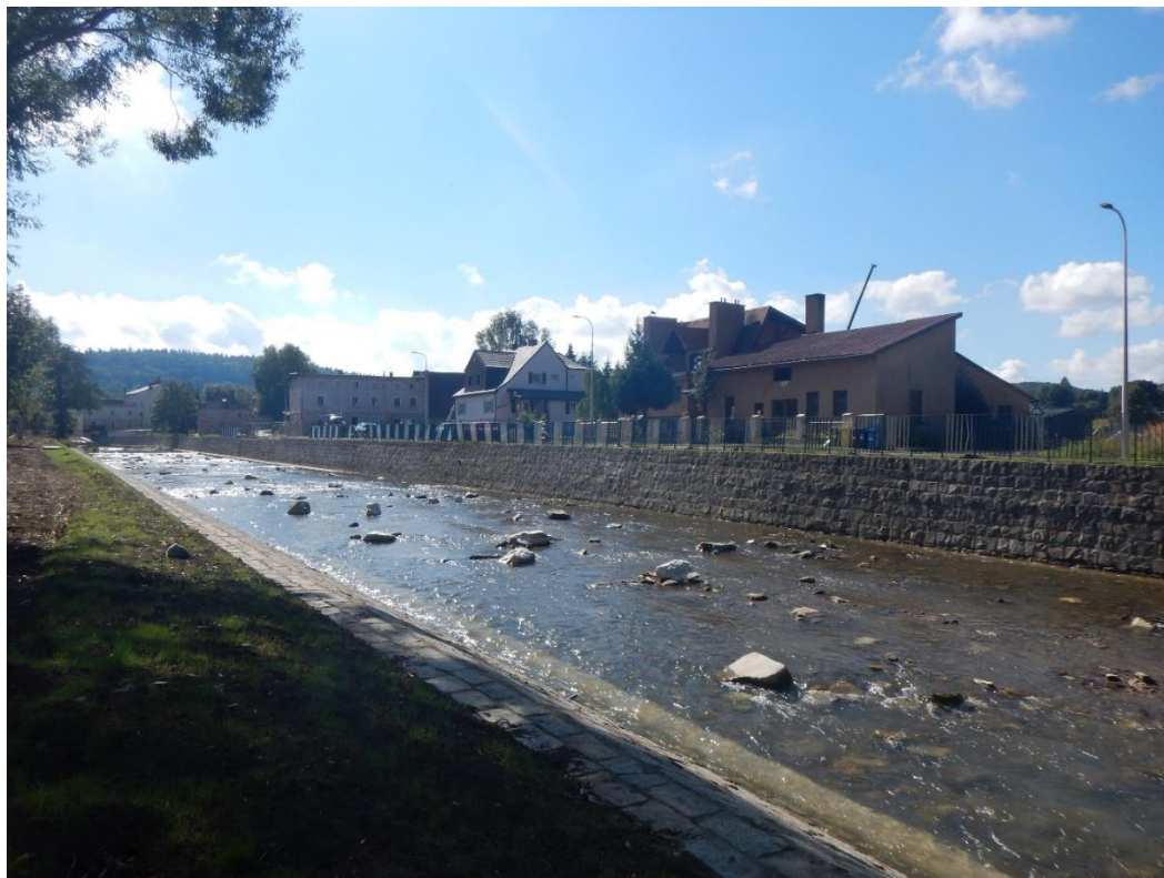
Fot. 11. Mikrosiedliska dla ryb w korycie rzeki wykonane po zakończonych pracach budowlanych (poz. 72).
