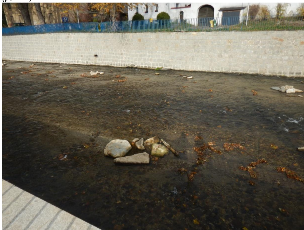
Fot. 12. Mikrosiedliska dla ryb w korycie rzeki wykonane po zakończonych pracach budowlanych (poz. 72).
